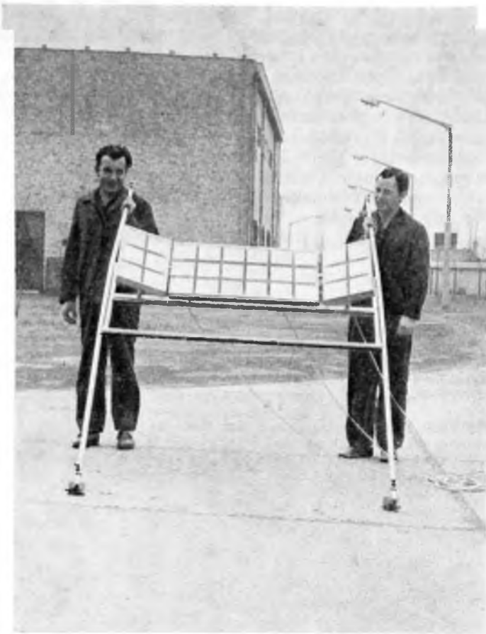
25-8. ábra. 22 W névleges teljesítményű napelemes telep szerelten
